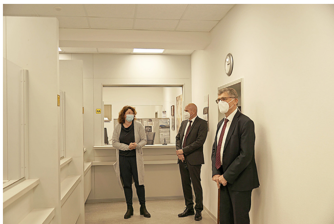
Landrat Reinhard Krebs und Vizelandrat Udo Schilling besichtigen mit Michaela Meifarth vom Liegenschaftsamt die renovierte Zulassungsstelle in der Thälmannstraße
